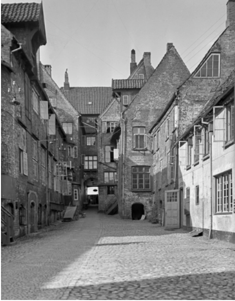
Abb. 8: Blick in die Hinterbebauung des Schädelschen Hofes in Flensburg (Foto 1932)
